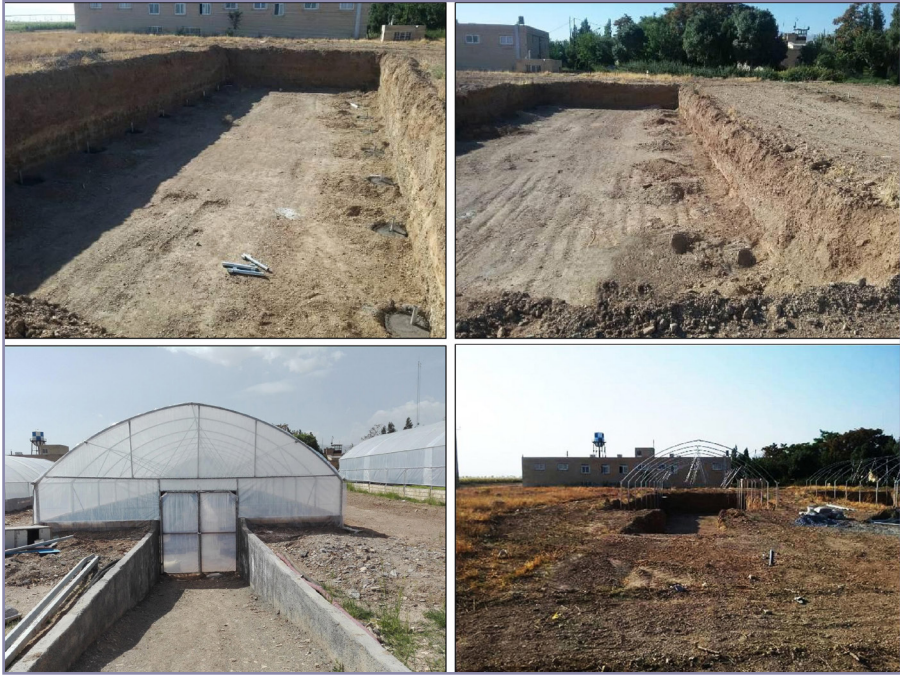
شکل ۵- مراحل مختلف ساخت گلخانه‌ی زیرزمینی
